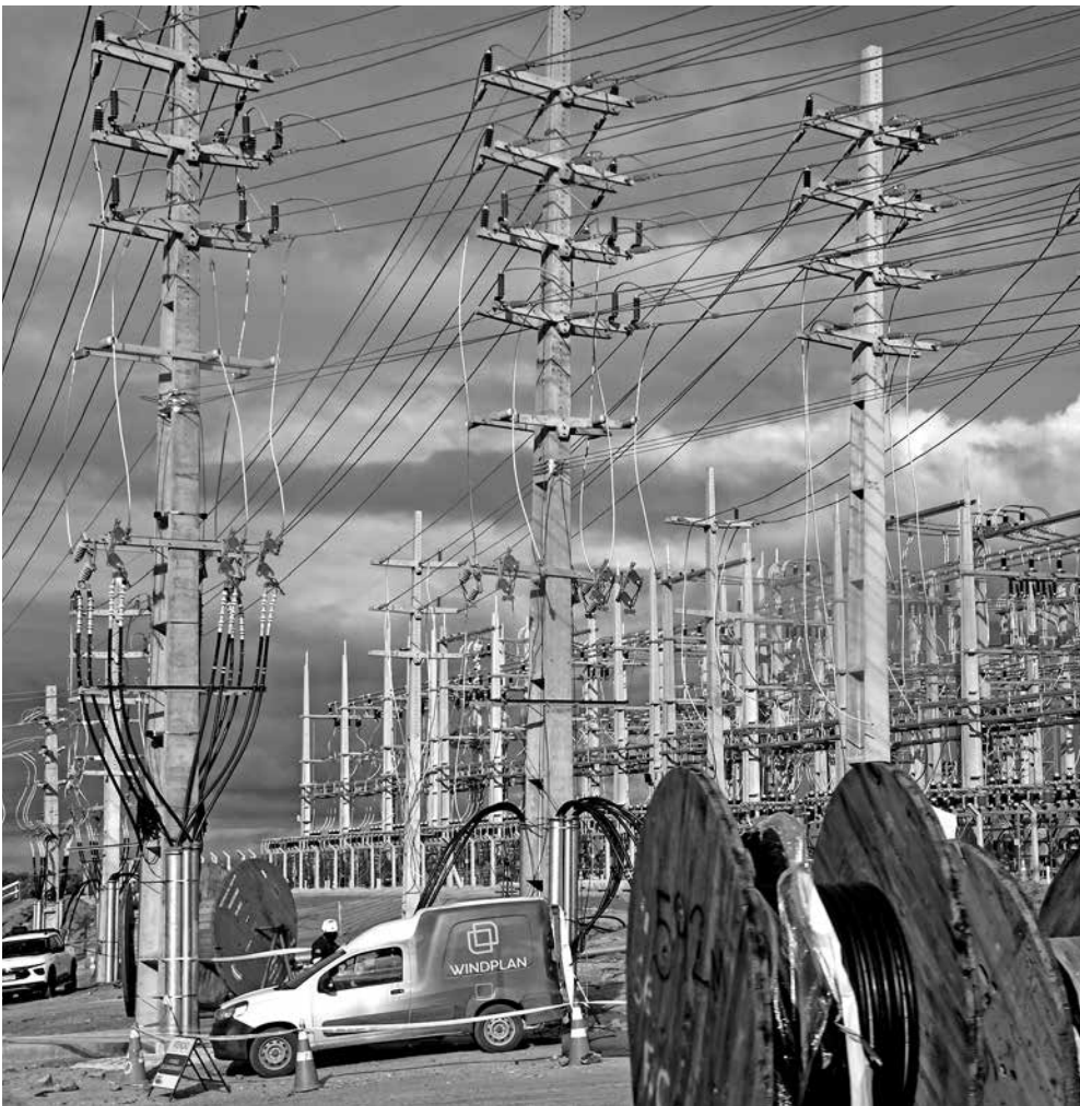
Transformadores converterão a tensão inicial, de 34,5 quilovolts (kV), em tensão de 500 kV
